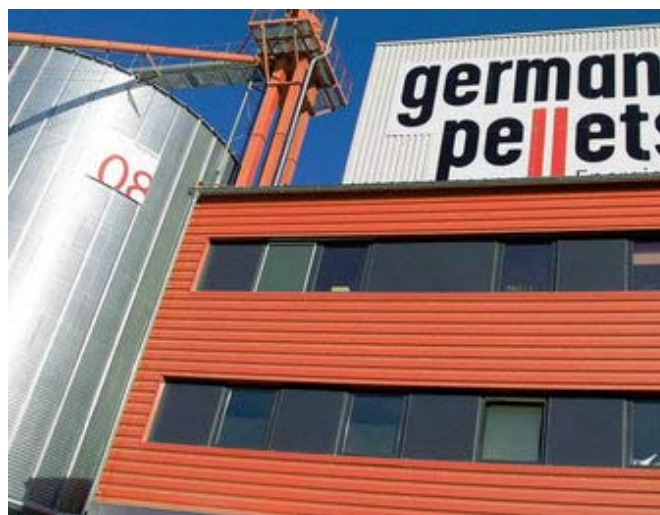
Die Löschanlage des Ettenheimer German Pellets-Werks hatte den Brand schnell im Griff. Er war in der Hammermühle entstanden. | Foto: Katharina Meyer
